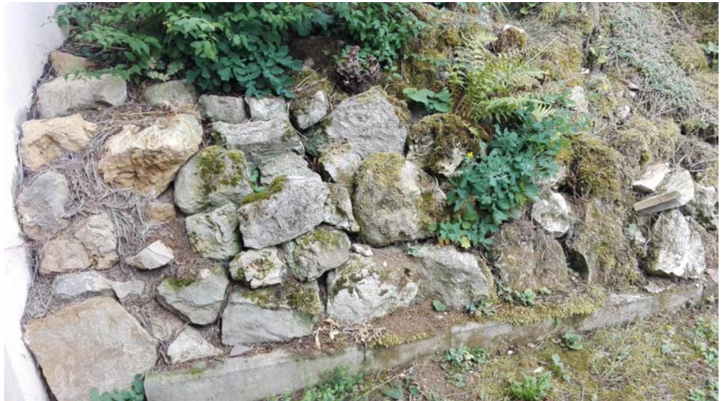
Abbildung 8: Trockenmauer entlang der Zufahrt zur Garage auf dem Grundstück mit der Flurstücksnummer 233
