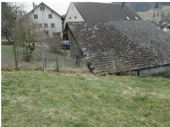
Zum Stöckleweg hin ist ein offener Geräteschuppen vorhanden.
